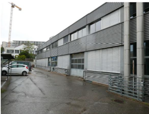
Photo 1 : façade sud du bâtiment
